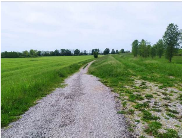
Lungo argine del Versa (tratto sulla sommità) tra strada Merlanis a Mariano e confine comunale con Romans d'Is.
