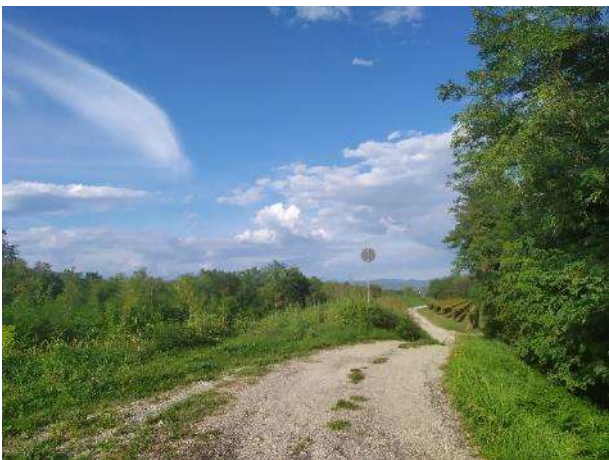
Lungo argine del Versa (tratto sulla sommità) tra ponte ex ferroviario e ponte via Cormons
