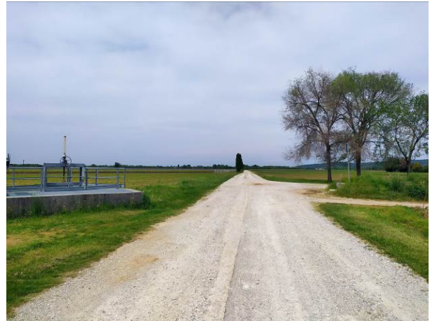
Strada Forchiattis presso passaggio su canale principale III tronco
