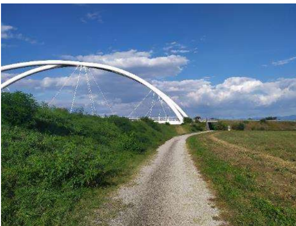
Lungo argine del Versa presso ponte SR 305 var
