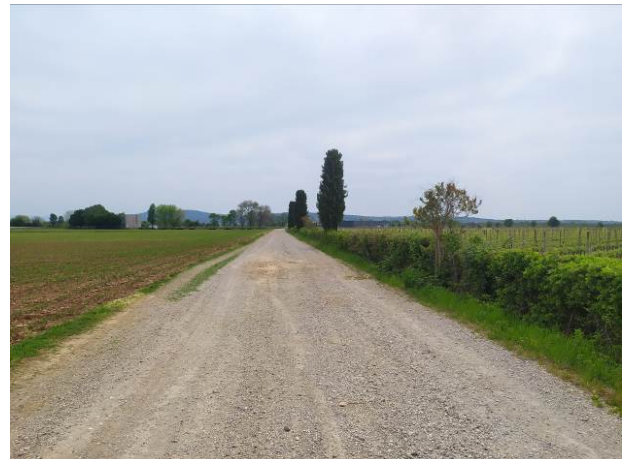
Strada Forchiattis tra confine comunale con Romans d'Is. e passaggio su canale principale III tronco
