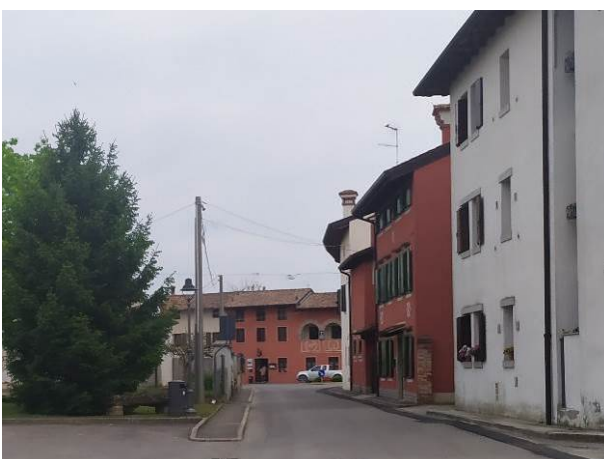
Tratto stradale con condivisione spazi non ottimale (es. via della Chiesa a Corona)
