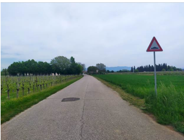
Strada della S. Trinità tra sottopassaggio SR 305 var e via Campo sportivo a Corona
