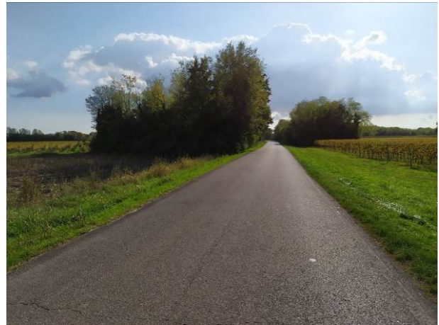
Via Cormons tra ponte sul Versa e Corona
