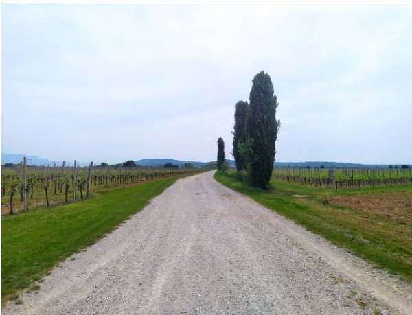
Strada Forchiattis tra confine comunale con Romans d'Is. e passaggio su canale principale III tronco
