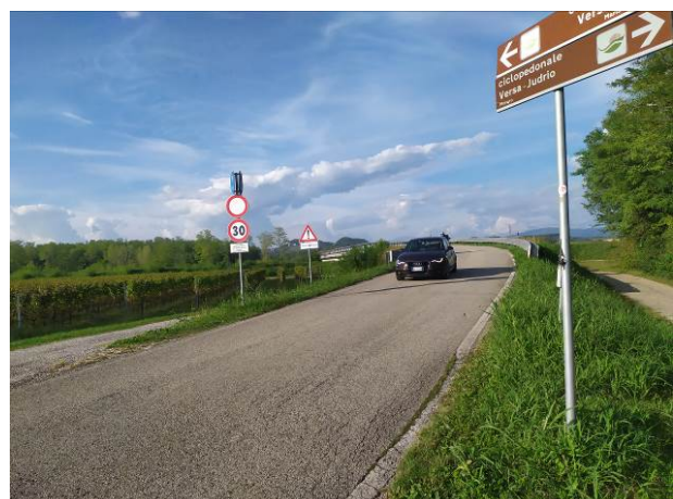
Ponte con condivisione spazi non ottimale (es. ponte via Cormons su Versa)
