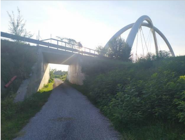
Lungo argine del Versa sottopassaggio ponte SR 305 var
